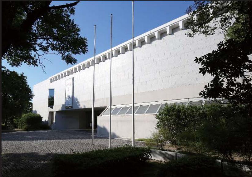
写真3 エントランス南東より
