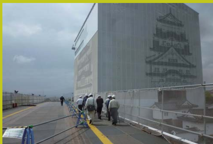
2011年4月 見学会（姫路城改修工事）
