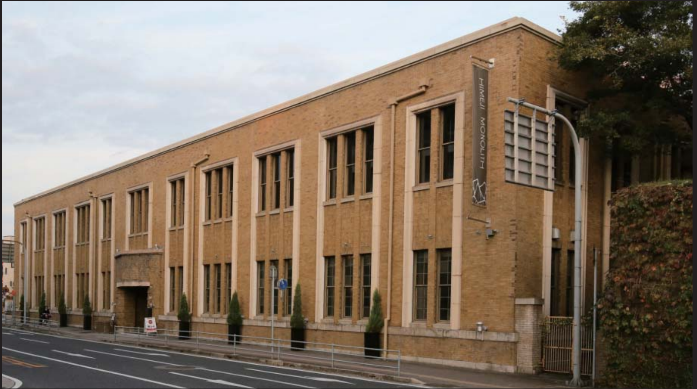
北西より全景
