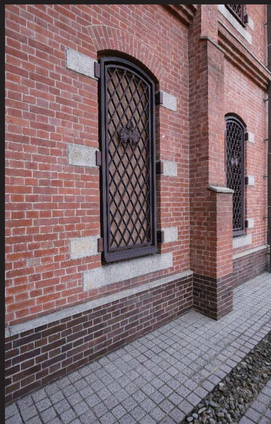
写真6 窓周り・柱のディテール
