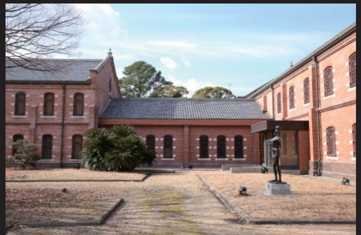
写真3 増築による西館と北館の接続部
