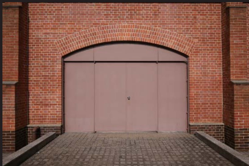
写真4 西館南の搬入口
