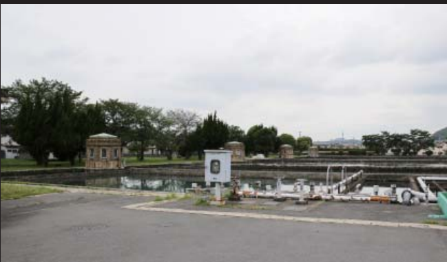
写真5 濾過池と節制室
