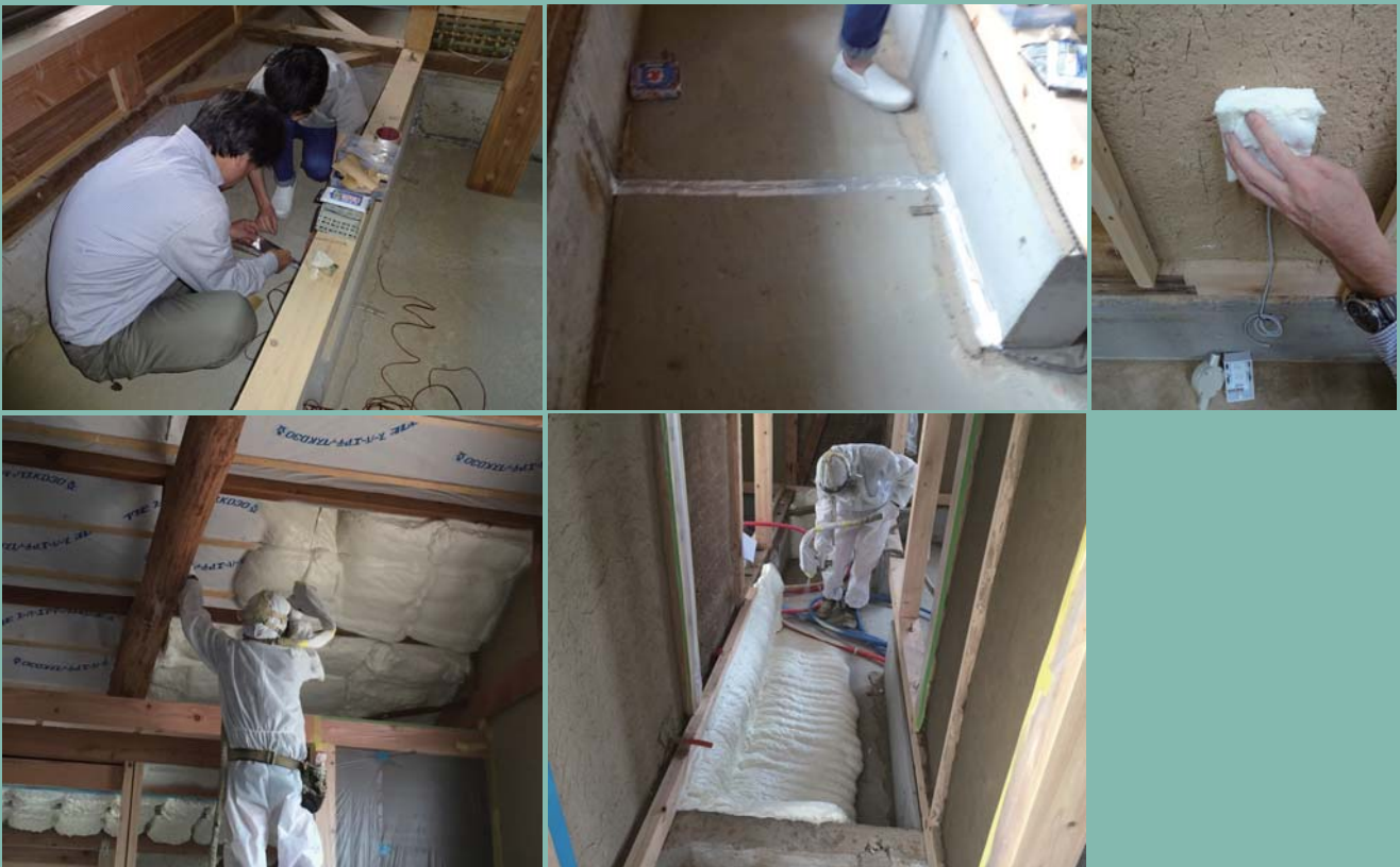
上 温湿度測定器の設置 下 吹付断熱材の施工状況 (報告 山田副支部長)
