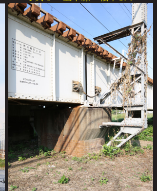
写真5 下り線T型柱脚
