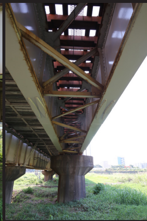
写真2 上り線 橋下より
