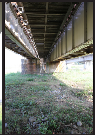
写真3 上下線 橋下より
