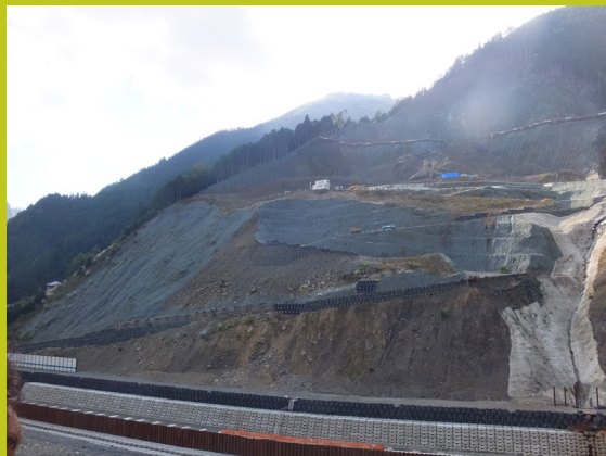
2015年10月 奈良県 十津川村谷瀬の 吊橋付近崩落復旧工事カ所
