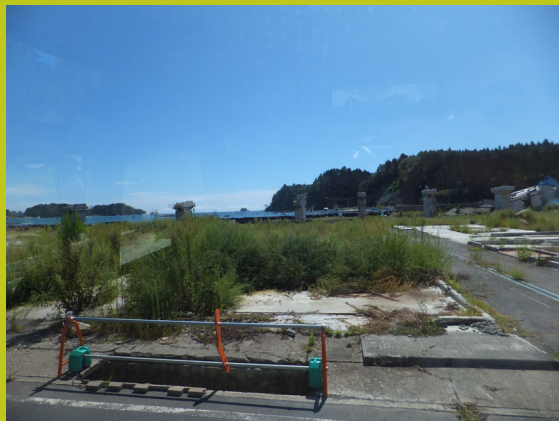
2012年9月 南三陸町 建物崩壊後
