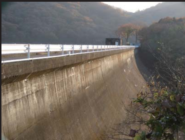
写真4 堰堤北より重力式ダムを見る
