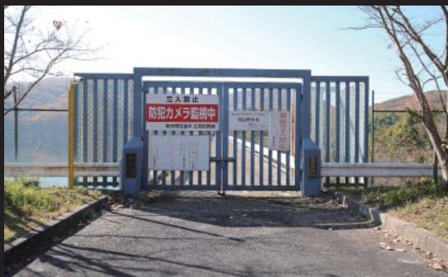
写真5 堰堤北側にあるゲート
