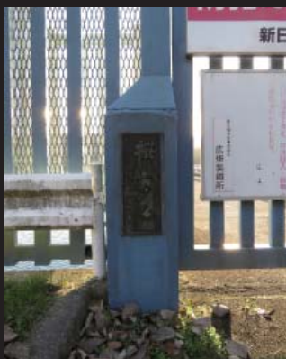
写真6 ゲート門柱のプレート
