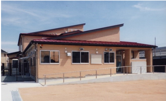
2017年竣工 加古川市 第二はとのさと保育園
