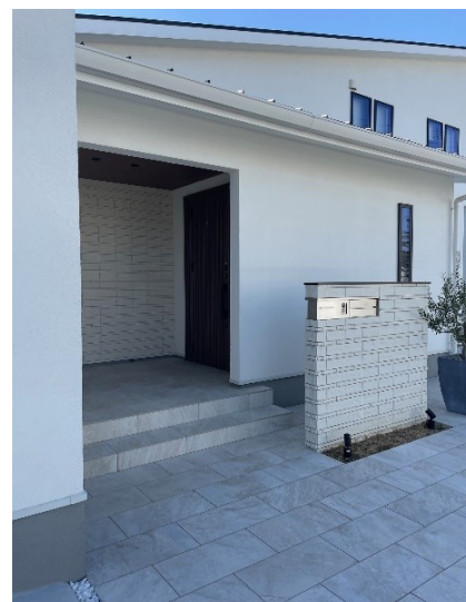
外壁はモルタルの上吹付塗装
