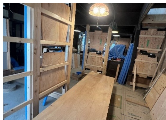
網干区新在家の築122年の古民家改修工事
