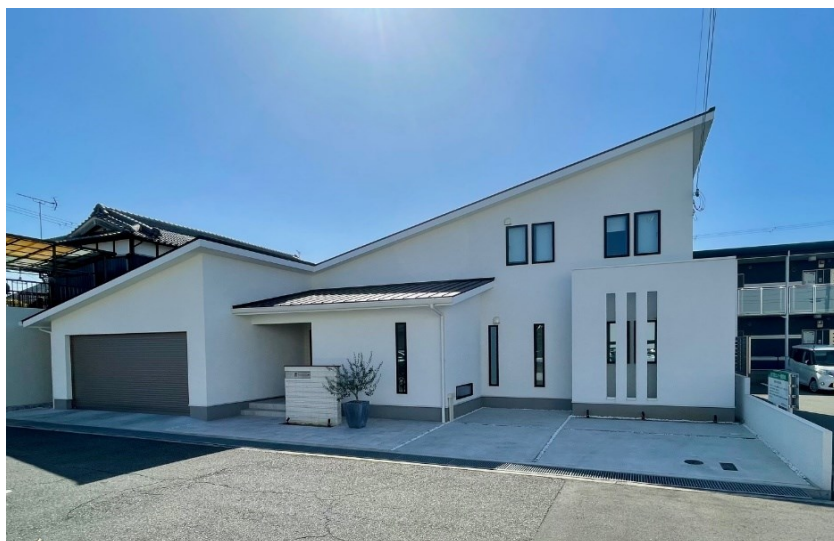
網干区垣内の片流れ屋根の家
