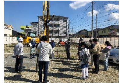
LP-SoC（丸太杭）工法による地盤改良
